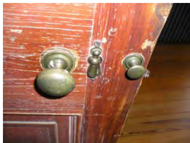
Fig. 4-174: Door hardware for door 29. (GWWO photo, 2005.)
